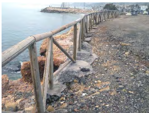
Zona de erosión de la costa por efecto del oleaje / Escollera de defensa
