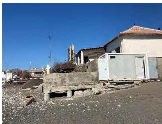
Daños en la Playa de la Araña causados por el oleaje del temporal de abril de 2022. Descalces, pérdidas de arena y escarpe producido por el oleaje.
